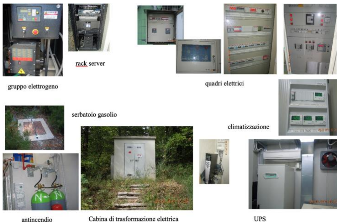
Figura 4 - Componenti della Rete Radar Nazionale del DPC.
